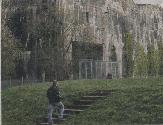
Der riesige U-Boot-Bunker „Valentin“ im Bremer Stadtteil Farge soll zu einer Gedenkstätte ausgebaut werden. Foto dpa
