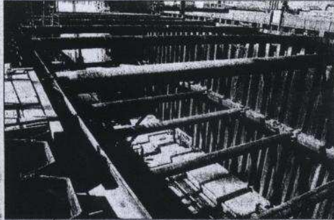
Gewaltige Dimensionen: So sieht die Baugrube des Binnenhauptes aus. Foto: stp
