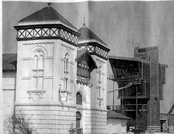
Der Gegensatz von Alt und Neu: Das Alte Kraftwerk liegt neben der neuen Zentrale der Kaiserschleuse. Foto eer
